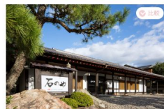
伊豆長岡温泉 (静岡県) 伊豆長岡温泉 Villa Garden 石のや
